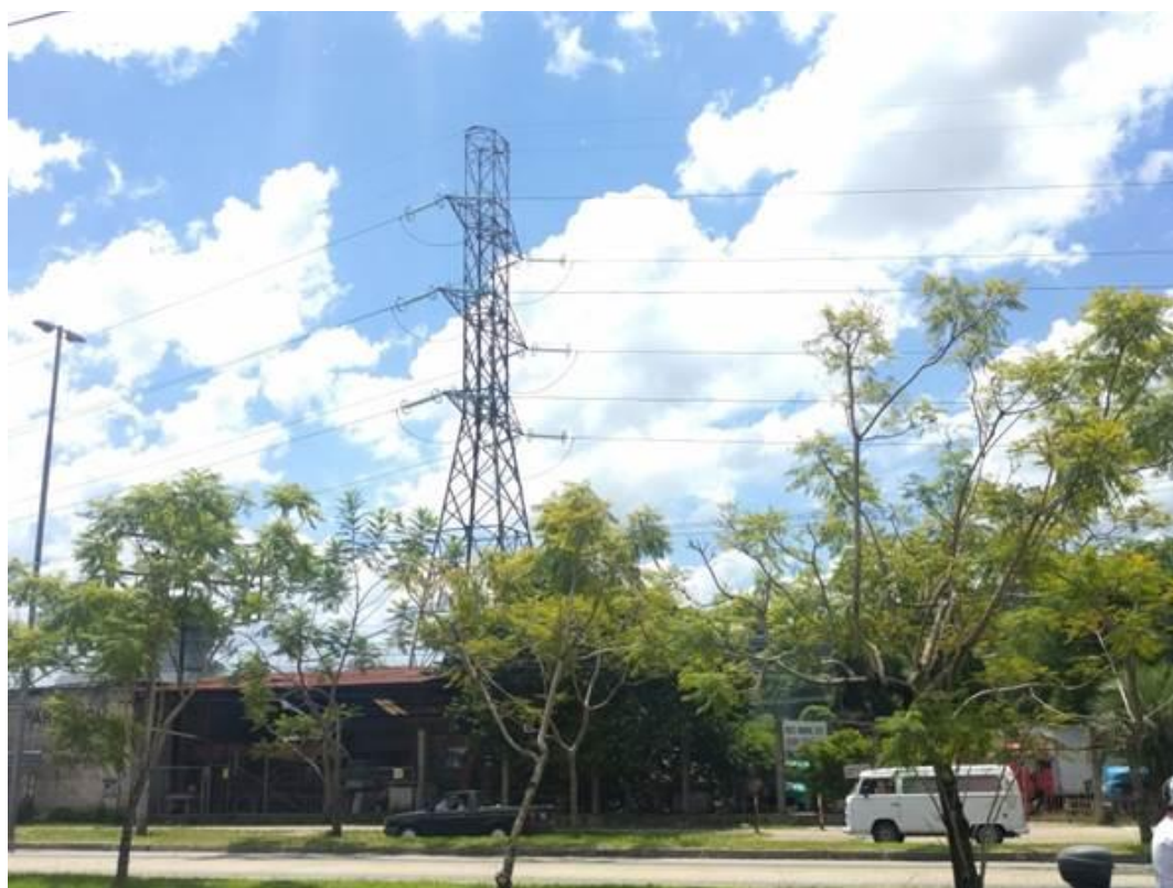
Figura 207 - Possível torre para seccionamento (visita de campo em 07/02/2018)
